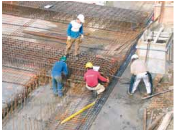
Pose d'armature sur chantier.
