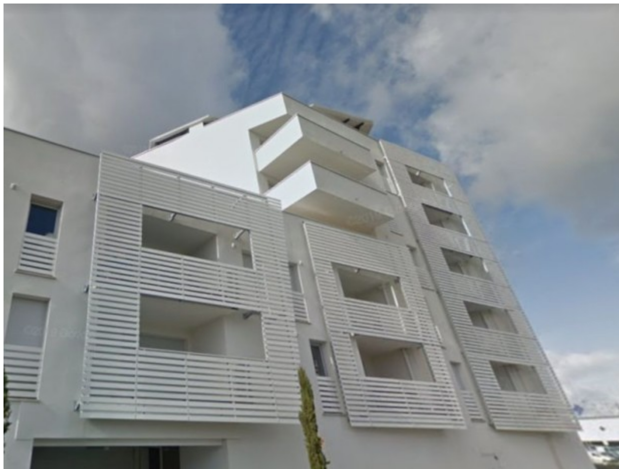
Balcons menacés à Cenon (33) © Google street view
